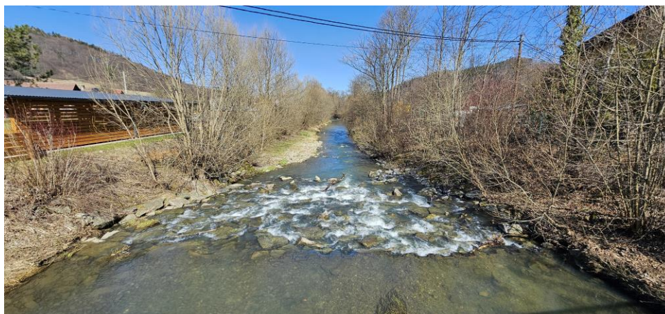
Obrázek 1: pohled na balvanitý skluz z mostu u OÚ, foceno 19. 3. 2025
